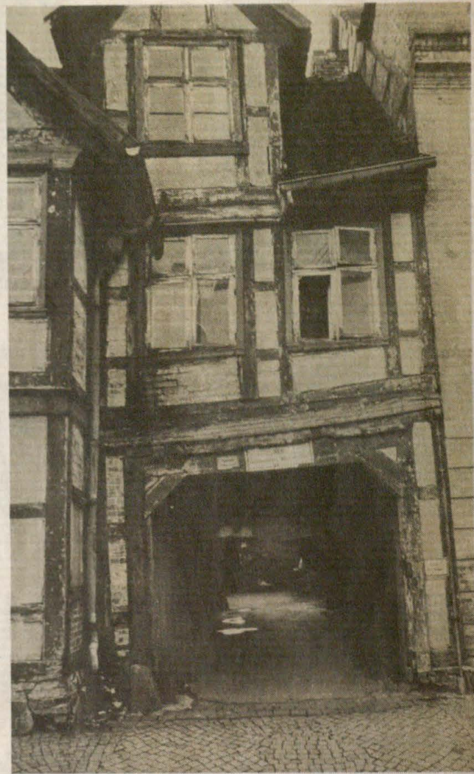
Die Einfahrt zu den Galvanischen Werkstätten in der Puschkinstraße.
