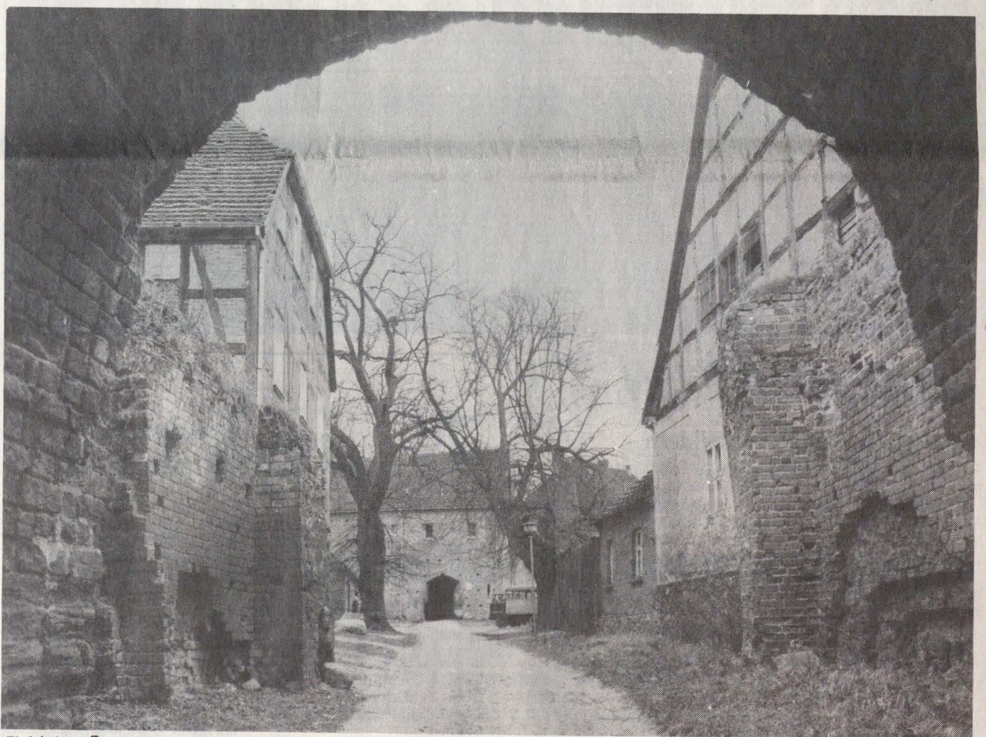
Einfahrt zur Burg.
