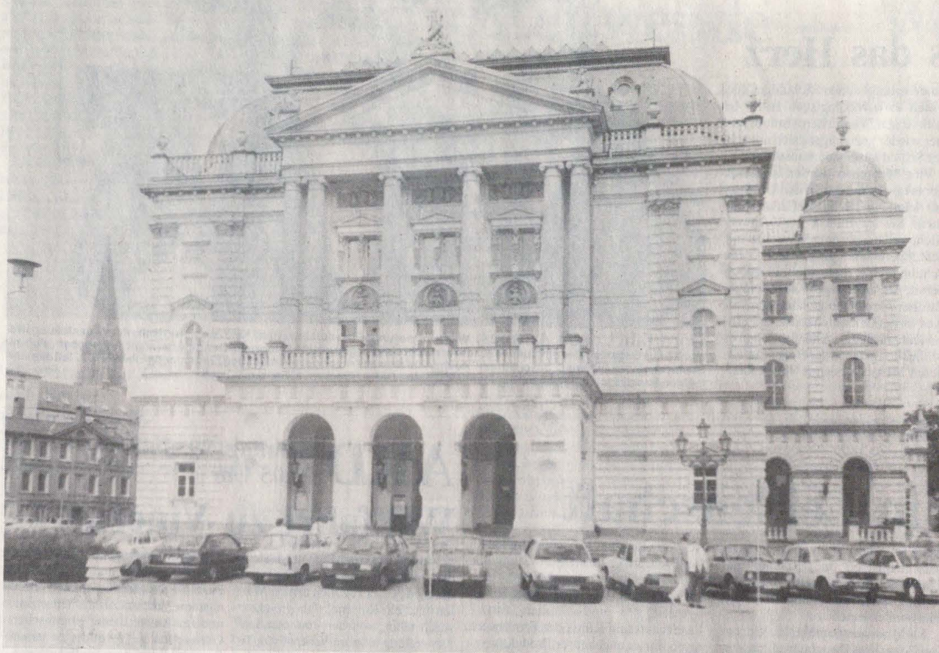
Der Schein trägt: Hinter der blendenden Fassade rieselt der Kalk
