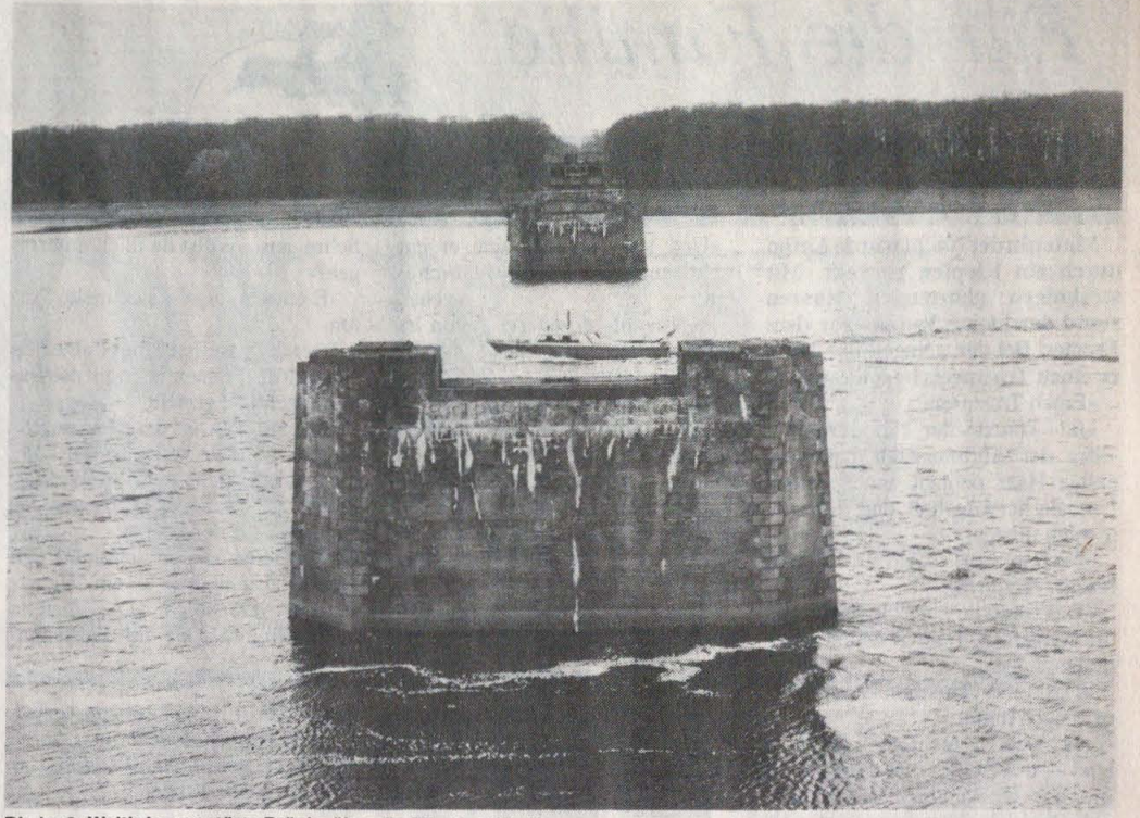
Die im 2. Weltkrieg zerstörte Brücke über die Elbe bei Dömitz.
