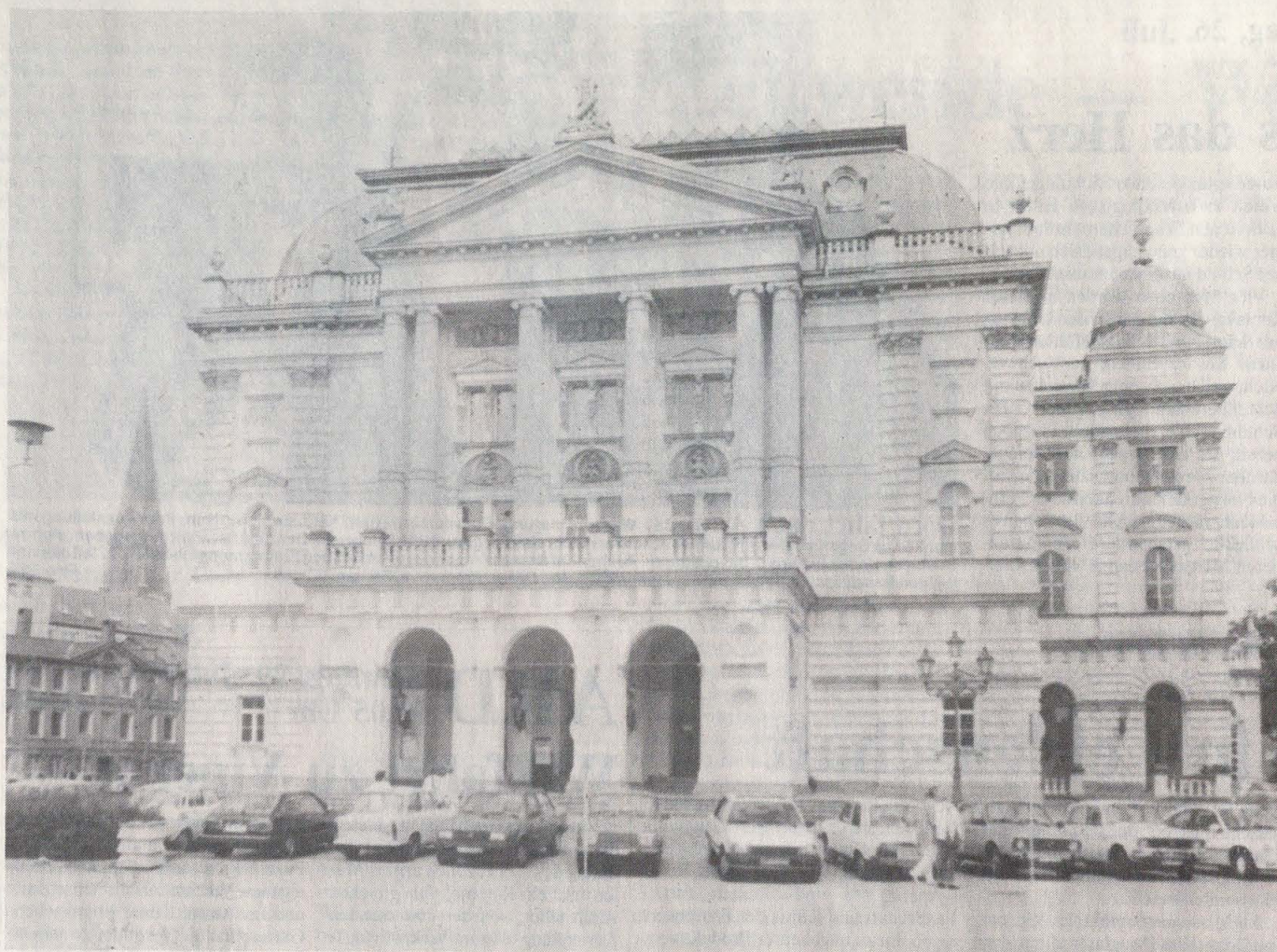
Der Schein trägt: Hinter der blendenden Fassade rieselt der Kalk
