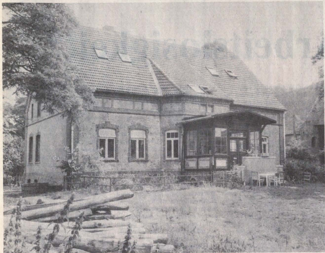
Das Pfarrhaus in Boitin ist das Zuhause der Wohngemeinschaft „Arche“. Hier wohnen Behinderte und Nichtbehinderte zusammen.
