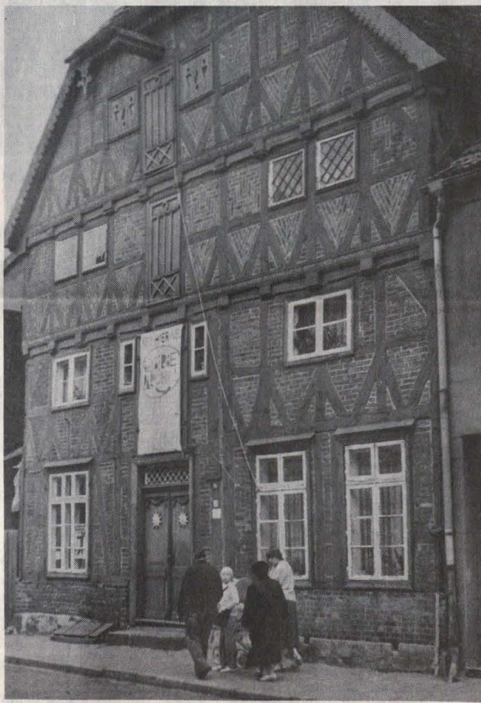
Eines der ältesten Bürger-Fachwerkhäuser
