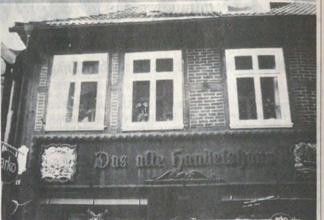
Das alte Handelshaus schmückt bereits ein neuer Blickfang. Gefertigt und montiert von der Menck-Fenster GmbH aus Schwerin.
