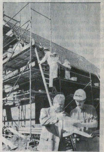
Baustelle Seehof bei Schwerin
