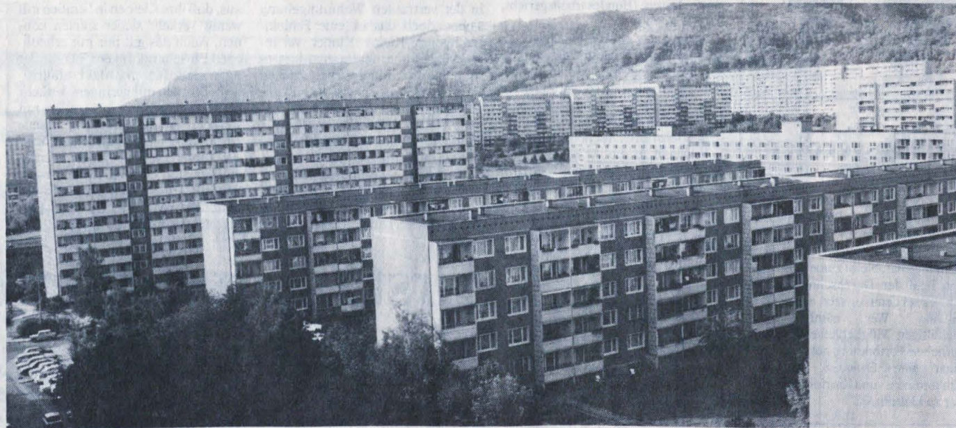
Jena Lobeda — eine soz. Großsiedlung inmitten der Landschaft, hier wurde jegliche bauliche Individualität abgelehnt.
