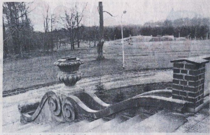
Munitionsbunker im Schloßpark
